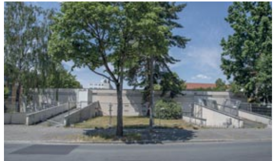
Die einstige Garagenanlage wurde abgerissen; bis zur Neubebauung sollen dort Stellplätze entstehen. Foto: Axel Rieger
